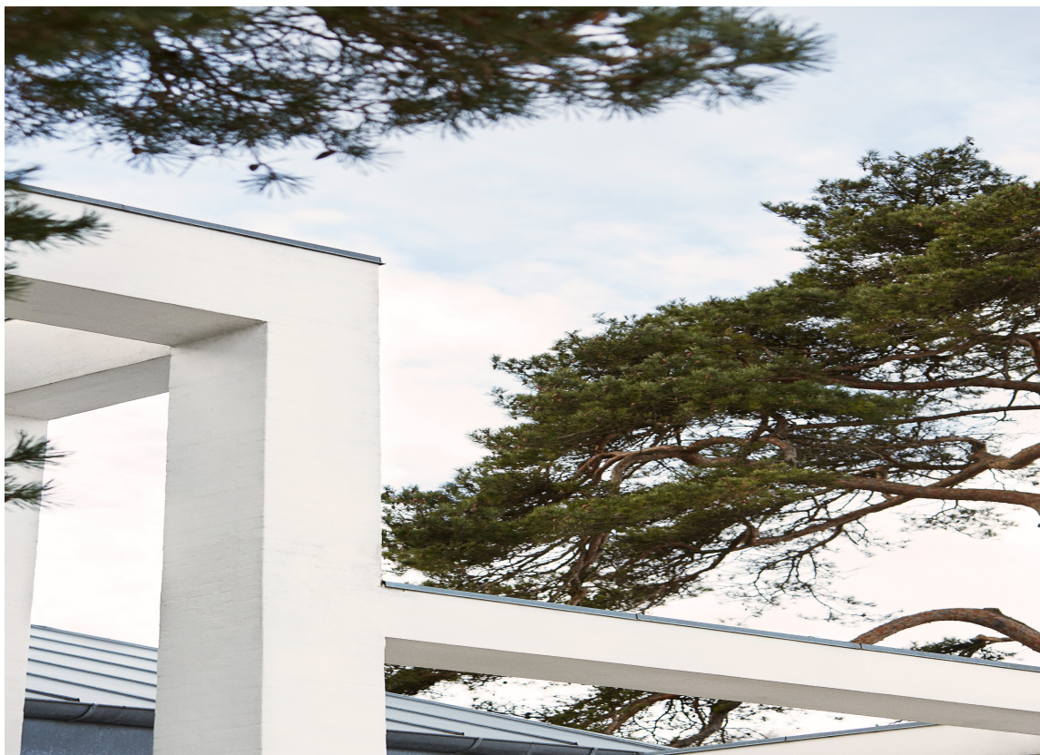
MUR OG PUSS: Det nye utendørs fargekartet fra 2022 er fylt med både klassiske og moderne farger til pussede fasader.
