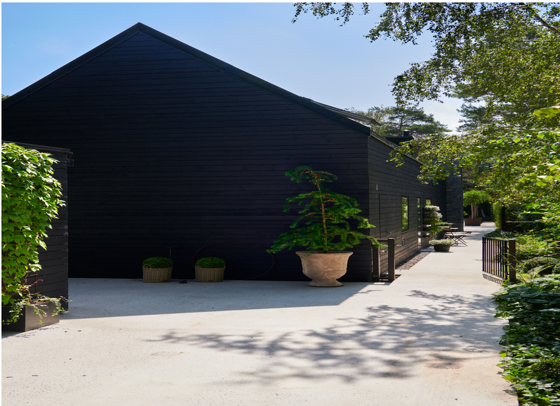
ELEGANT: Elegant grått og svart er et sikkert fargevalg på moderne og tidløse beisede hus. Du kan velge svale nøytrale sorte farger, eller en varmere og mer naturlig tone.
