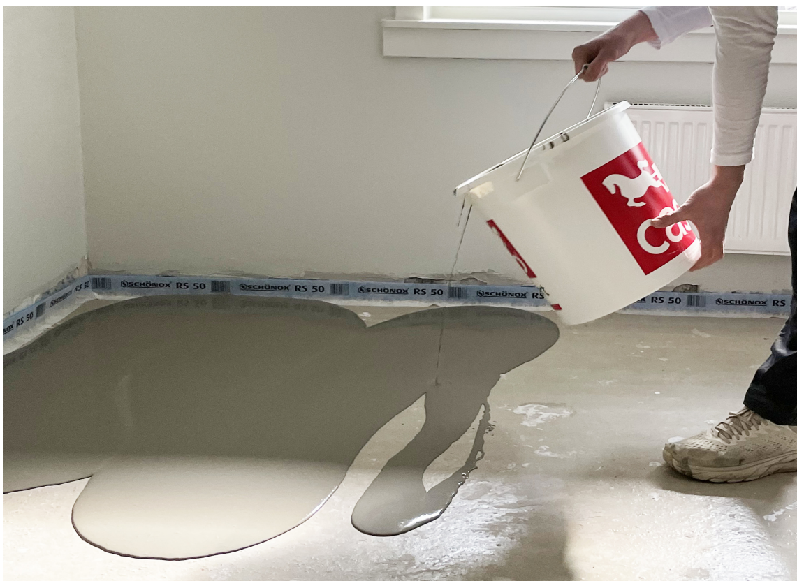
HELL UT: Avrettingsmassen består av et sementbasert pulver som blandes med vann i en vanlig bøtte. Når alle klumper er blandet ut, helles innholdet i bøtten ut over gulvet.
