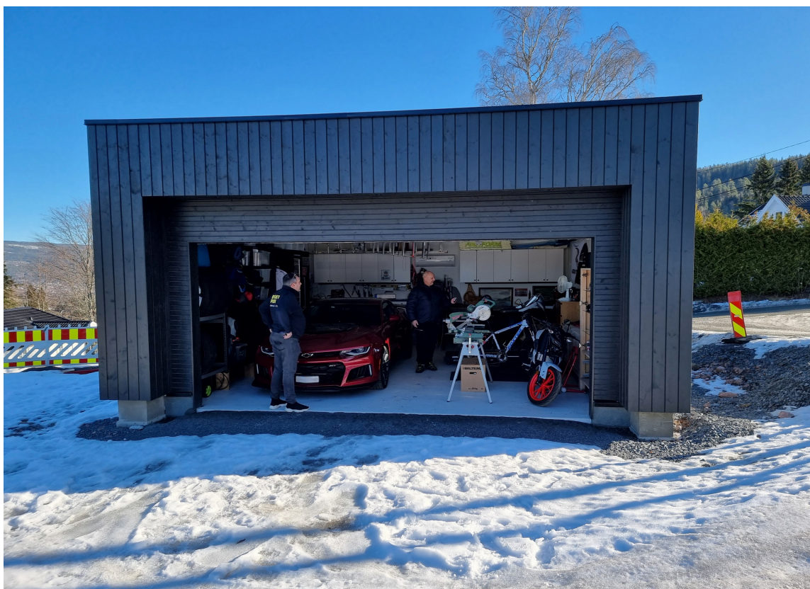
GODKJENT: Tore Erik Hammer er daglig leder hos Bygger'n i Drammen. I dag er han på befaring hos garasjekunde Johan Olaf Førde. – Det har vært en spennende prosess og gøy å se sluttresultatet. Dette er mer en godkjent, sier han.
