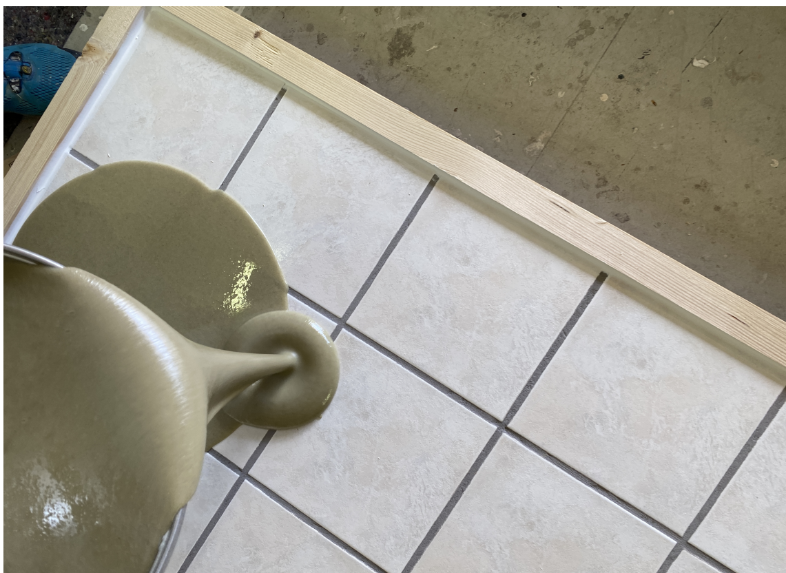
UJEVNT GULV: Med riktig primer blir et flisgulv jevnt og fint med Kabric Floor.
