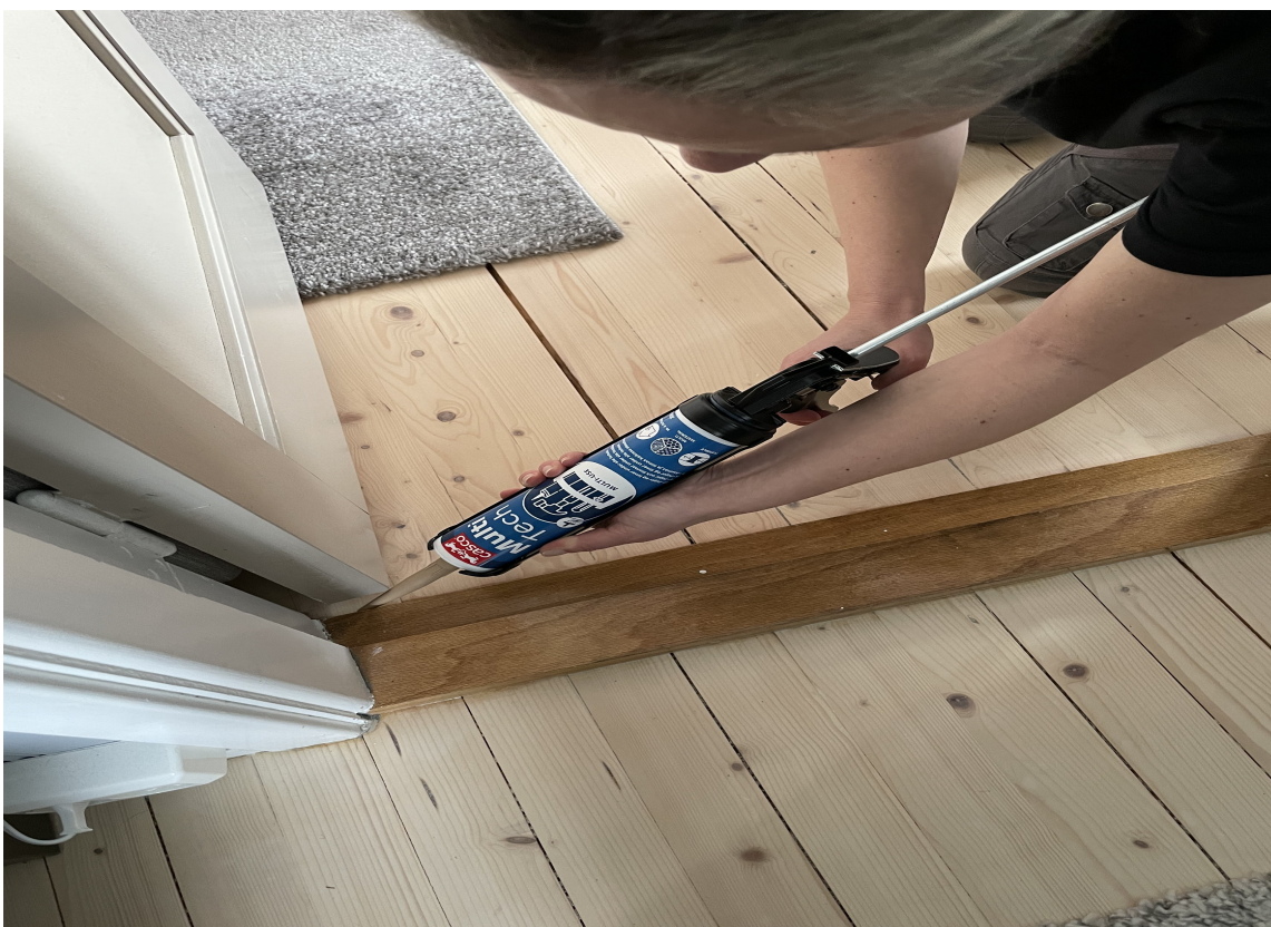
ULIKE UNDERLAG: Som fugemasse brukes MultiTech til både planlagte bevegelsesfuger, og til fuging og tetting i gulv, i hjørner, ved taket og rundt dører og vinduer. Massen hefter både på tre, betong og mur.
