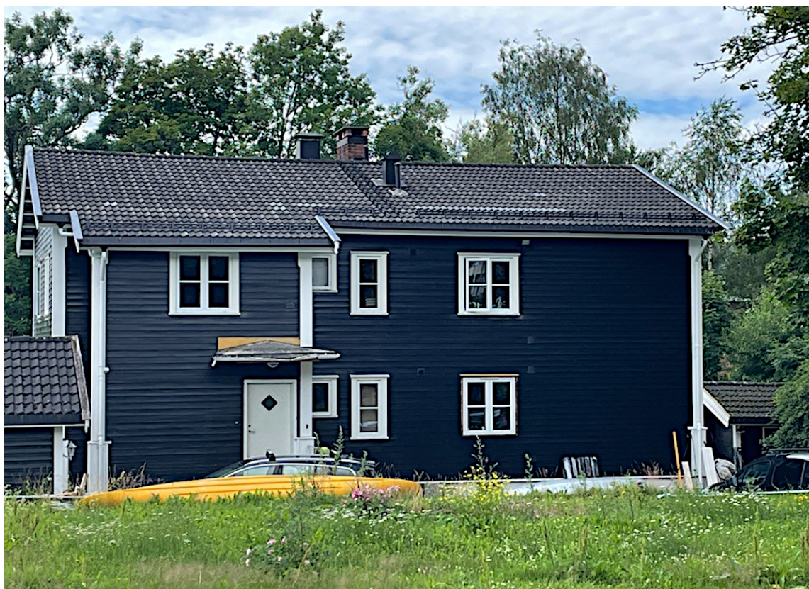
FERDIGMALT: Slik ser huset ut etter at det er blitt malt ferdig. Linoljemalingen fra Wibo ser blank ut den første tiden, men mattes gradvis ned.
