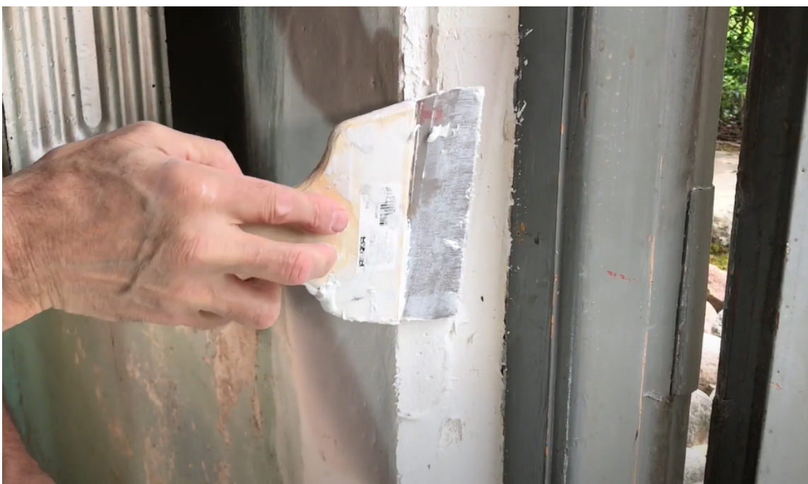
LETT Å FIKSE: Du har god tid på deg å få flaten glatt og jevn. Etter at pulveret er blandet ut, kan det bearbejdes og slipes på i 8 timer. Etter herding blir reparasjonen solid og fast. Pulver som ikke brukes med en gang, kan spares på et tørt sted. Casco HusFix kan pigmenteres og stå som ferdig overflate, men du kan også velge å male den sparklede flaten.
