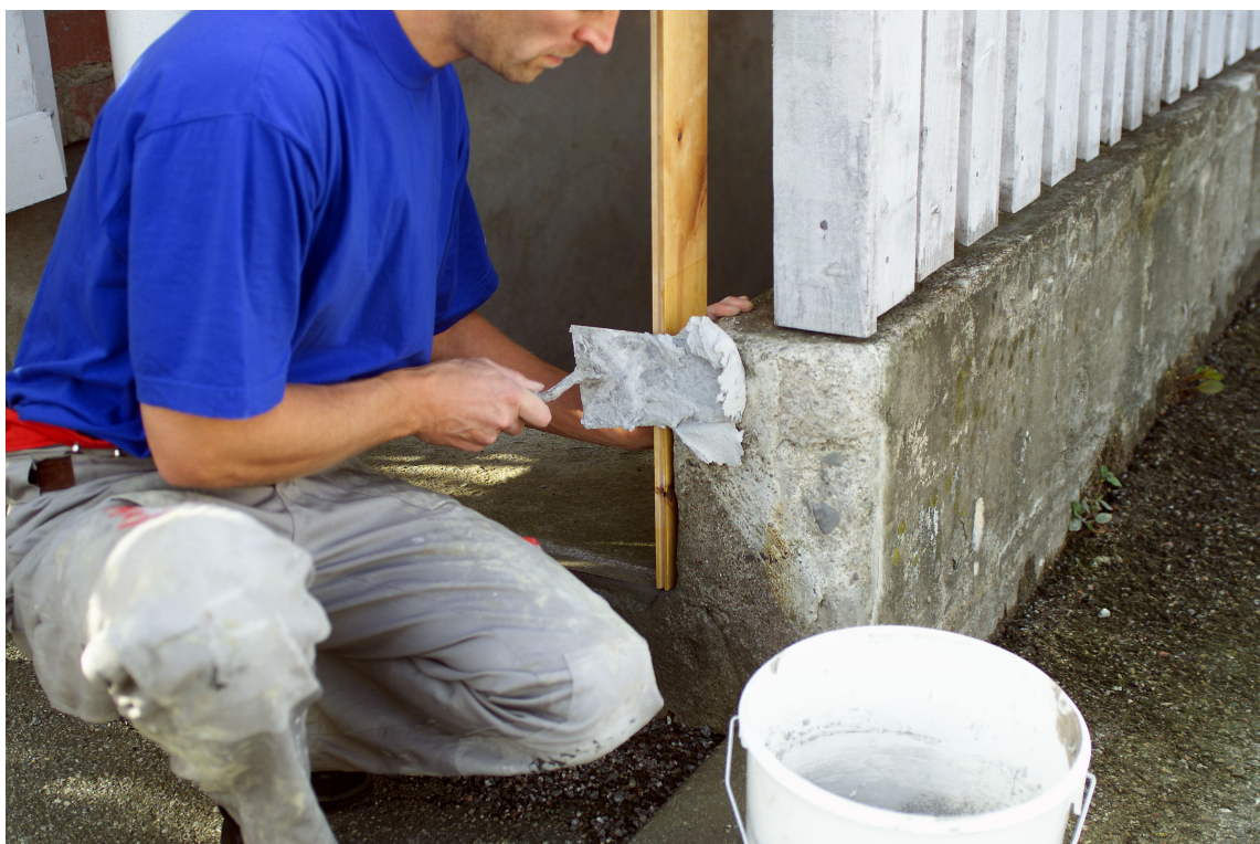
BYGG OPP HJØRNET: Et avskallet hjørne i grunnmuren er lett å fikse med Casco HusFix. Etter herding gir sementsparkelen et solid og holdbart hjørne.
