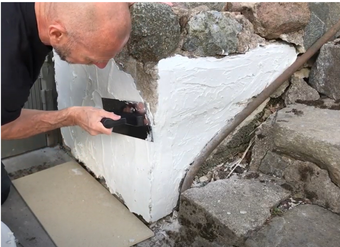
FIKSE MURVEGG: Teglsteinsvegger og steinmurer kan få et nytt utseende ved litt slemming med Casco HusFix. Du kan bruke sparkelmassen både ute og inne, og det er lett å få til et godt resultat. Påfør med bredsparkel, malerull eller med murskje.
