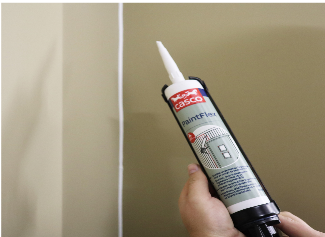
FLEKSIBEL FUG: Casco PaintFlex er en overmalbar fugemasse for innen- og utendørs bruk. Den brukes blant annet til å tette glipper i hjørner eller mot tak, skjule sprekker i panel og listverk eller tette små sprekker rundt dører og vinduer.
