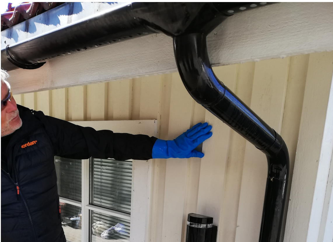
TRYGGE TAKRENNER: Et tips på Hussjekkdagen er å sjekke takrenner
