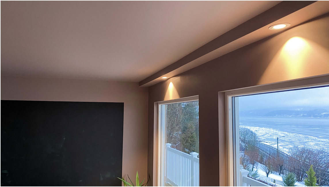
HJEMMELAGET SPOTKASSE: Spotkassen er laget med «INNKASSING L1 PU» fra Deco Systems, som originalt var 15x15 cm. Andreas har selv skjært til høyden for å passe hans preferanser.
