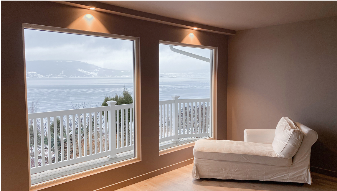
LISTEFRITT: Andreas har laget listefri løsning rundt vinduene på gamlemåten, med gipsforing, vinkeljern og sparkling. Neste gang skal han bruke smygplater.
