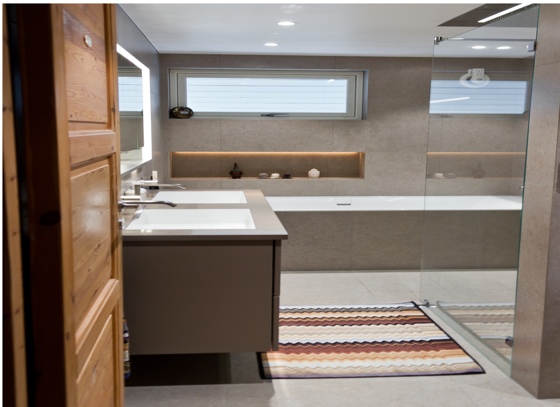
DELIKAT: Alle rør er lagt inne i vegg og rørapplegget er fornyet med et Sanipex rør-i-rør-system. Det er valgt samme flis på gulv og vegg, og de smale fugene møtes perfekt i overgangene.
