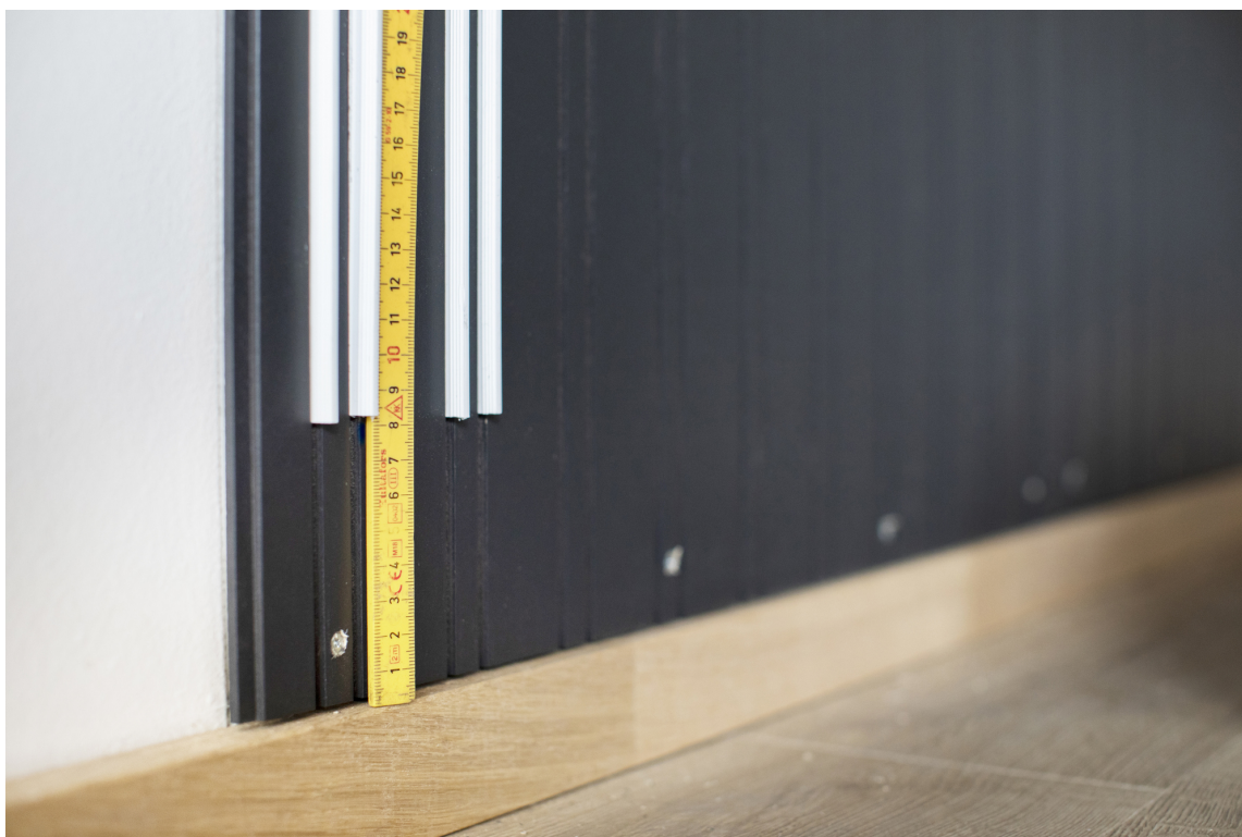
KLIPS PÅ: Når platene er på plass, er det enkelt å montere plastklipsene som holder spilene fast.
