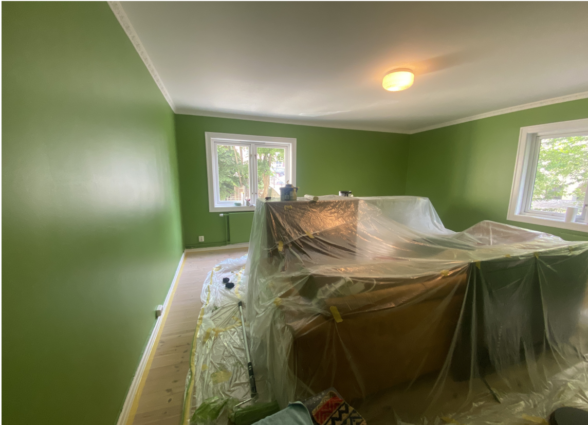
FORBEREDELSE: Vask veggen, maskér det som ikke skal males og dekk til møbler.
