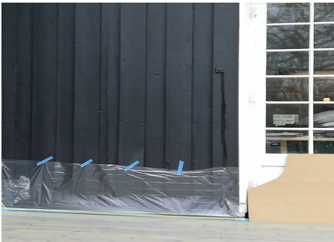
TILDEKKING: Beskytt malte flater, vinduer, aluminiumprofiler og annet som ikke skal ha etsende væske på seg. Bruk plast eller papp.
