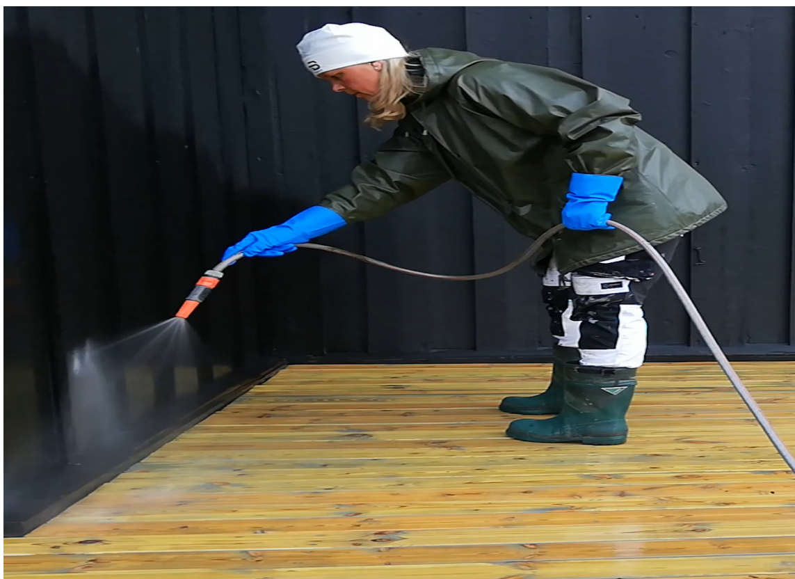
SKYLL VEGGEN: Til tross for god tildekking kan det ha sprutet beisfjerner på veggen ved terrassen. Skyll derfor for å vær trygg.
