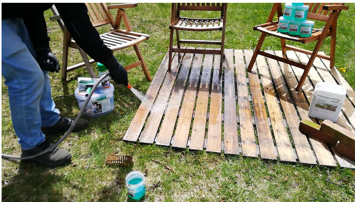
SKYLL GODT: Skyll med rikelig med vann etter at behandlingen er gjennomført.
