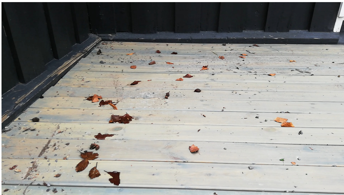
TERRASSE FØR: En årlig vask av terrassen forlenger levetiden både på treverket og overflatebehandlingen.
