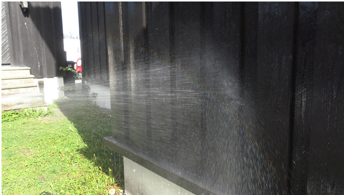
SKYLL NØYE: Skyll vekk all såpe. Bruker du høytrykkspylere, hold ca. en meter avstand mellom dysa og veggen.
