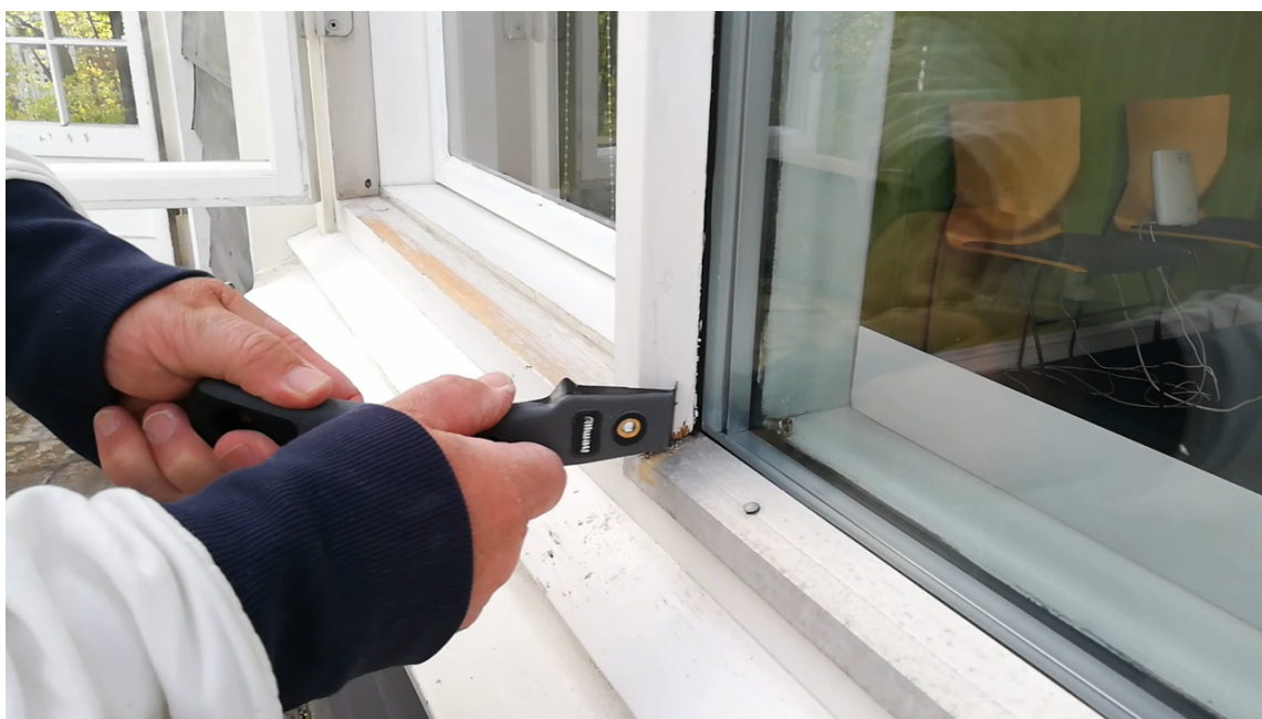
VANNFELLE: I løpet av året ligger snø, is og vann i kroker og kriker og tærer på malingen. Vær ekstra nøye med å skrape bort all løs maling her.
