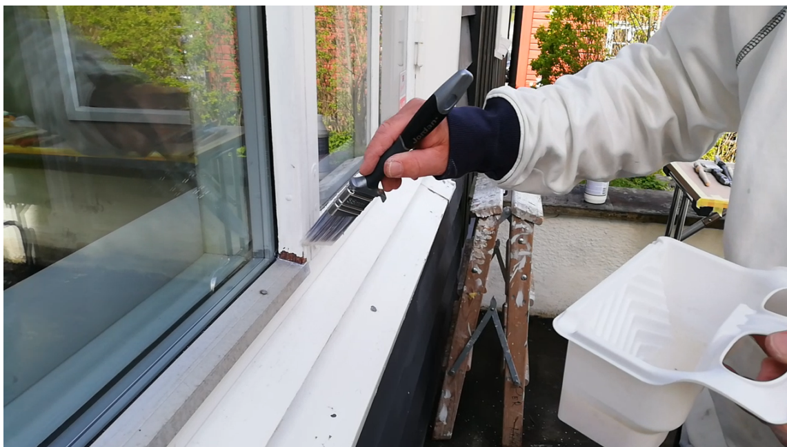
STOPP VANNET: Ved å påføre impregneringsolje, som trekker inn i treverket, hindrer du vannet i å trekke inn og unngår råte.
