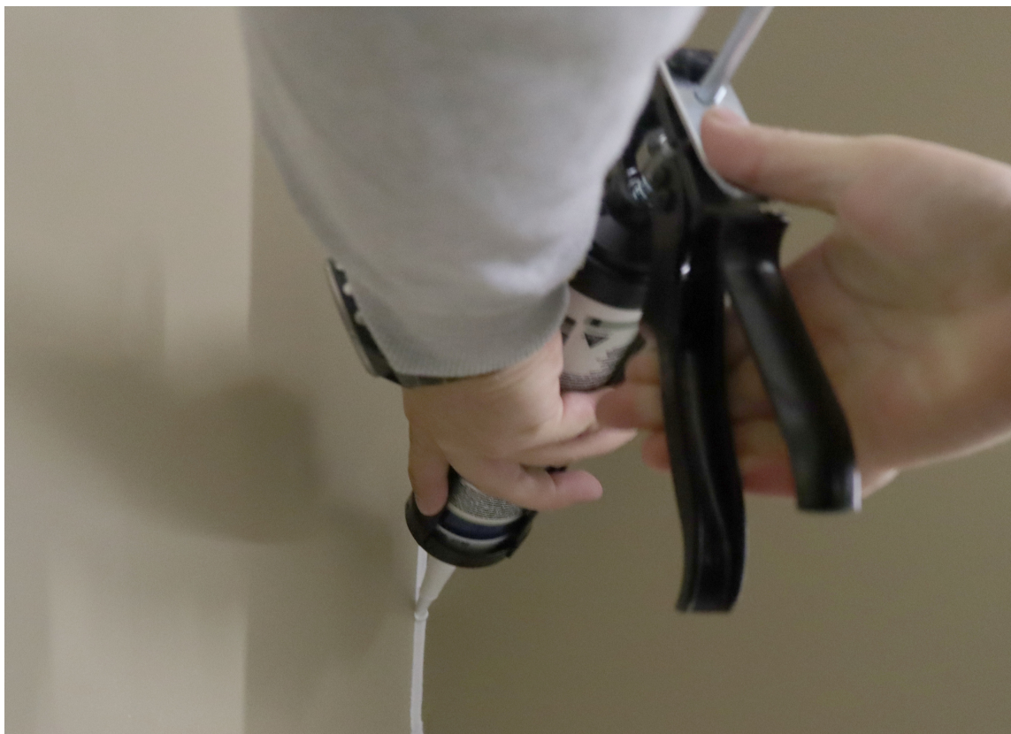
ENKEL I BRUK: Casco PaintFlex er enkel å påføre med fugepistol, og lett å glatte ut med en finger dyppet i vann.
