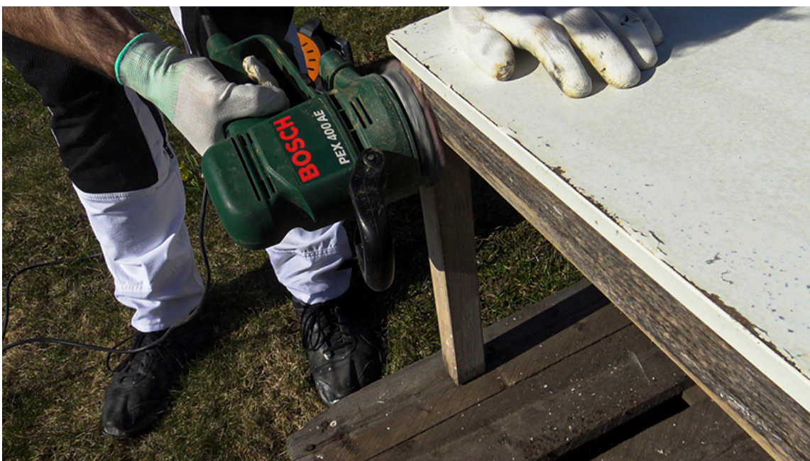
PUSS: Puss over med en hobby-slipemaskin.
