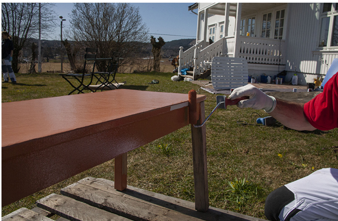
FØRSTE STRØK: Mal første strøk i ønsket farge Quick Bengalack. Bruk en liten rulle og en liten skråpensel.
