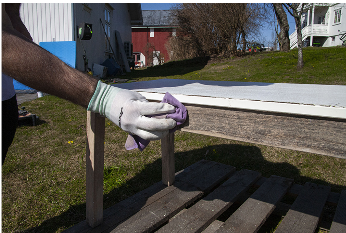
TØRK RESTER: Tørk bort sliperestene med en tørr mikrofiberklut.
