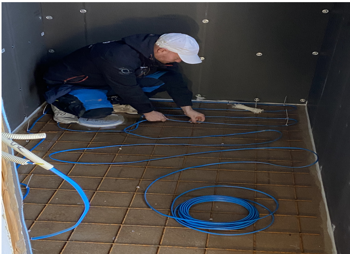
TOTALRENOVERING: Hele badet måtte rives og bygges opp igjen. Det tok i underkant av tre uker å få baderommet ferdig.
