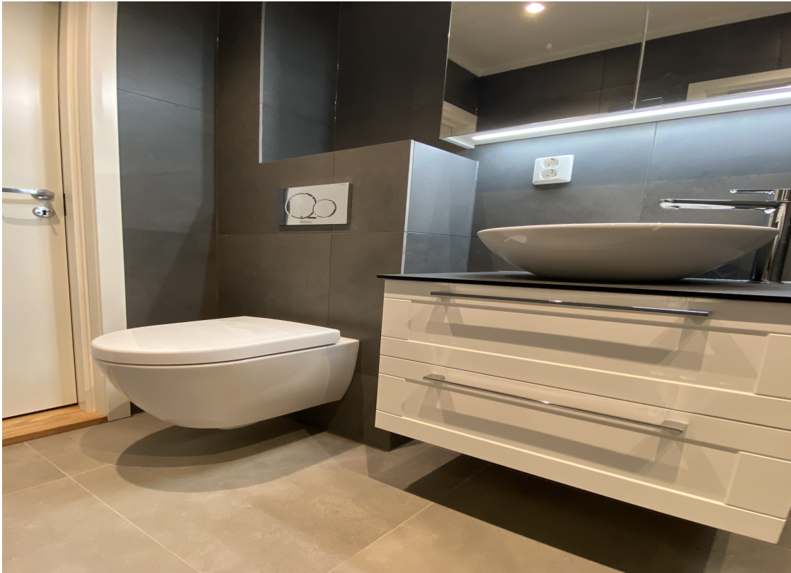
PREMIUM: Et veggengt WC med innebygget sistene fra premiummerket Villeroy & Boch gir god romutnyttelse og ekstra lagringsplass i nisjen. Servant, speilskap og servantskap er fra Korsbakken.
