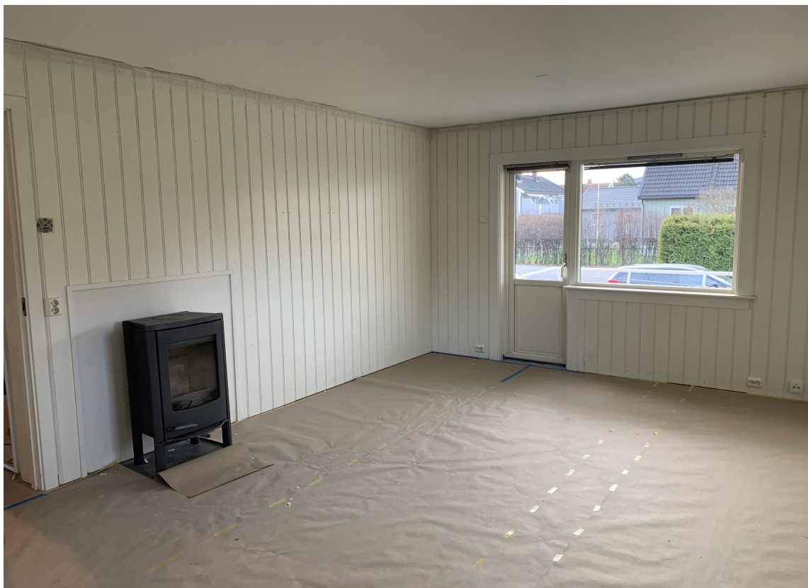
PANELPLATER: Her er stuen klargjort for ny stil og slette vegger. Veggene er rene og tørre, klar for oppsetting av Roll-on-wall.
