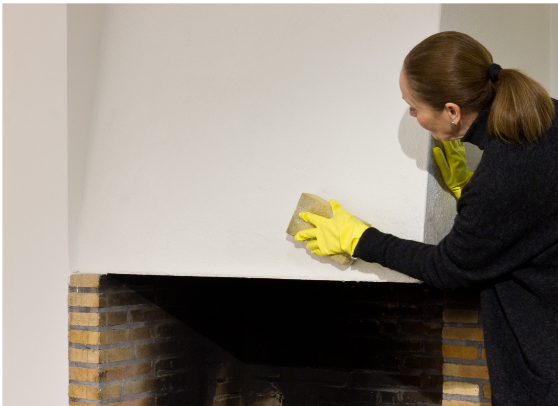
VASK: En grundig rengjøring setter grunnlaget for et holdbart resultat.
