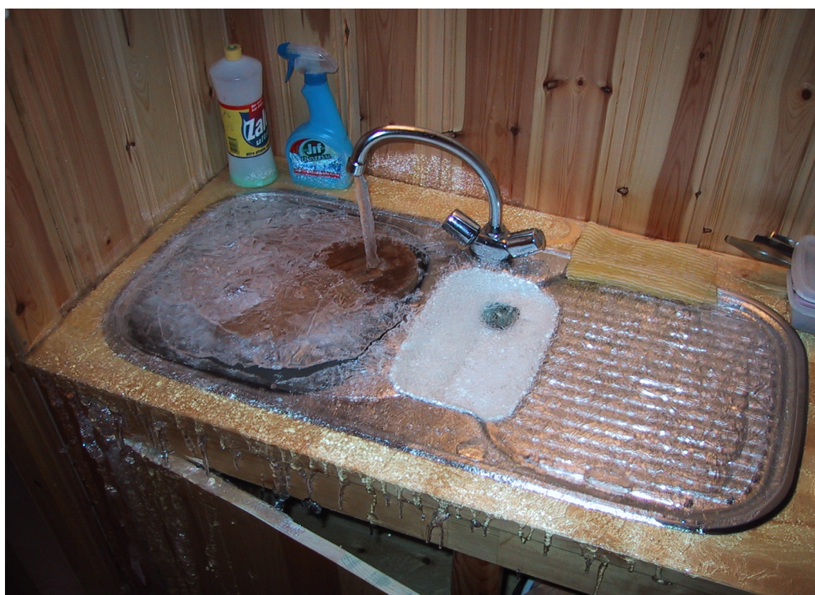
DYRE SKADER: Hvert år påfører vannskader norske hjem kostnader på over to milliarder. Som regel skyldes skadene lekkasjer fra vannrør.
