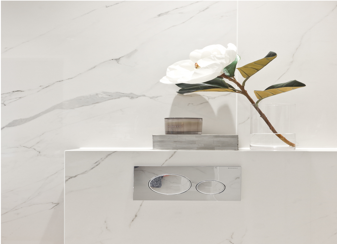
SJEL I DETALJENE: I alle ytterhjørner og rundt innbyggingssisternen har Acro bygg gjæret flisene istedenfor å bruke hjørnelister. Hjørnet er bygget opp med 2-komponent epoksyfugemasse, og fuget med samme masse. Etterpå er hjørnet polert.
