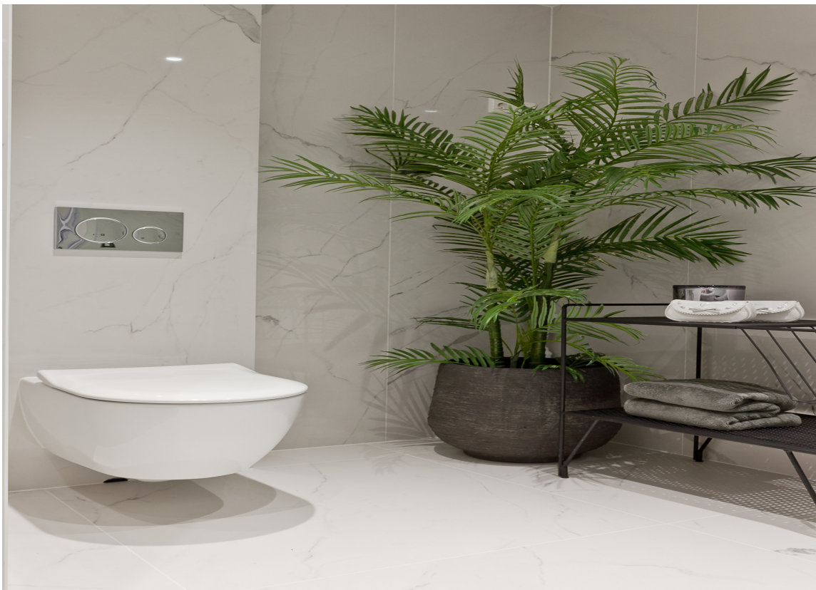
GODT HÅNDVERK: Flisene er kun 6 millimeter tykke, så arbeidet med å gjære fliskantene i 45 graders vinkel krever sin håndverker.
