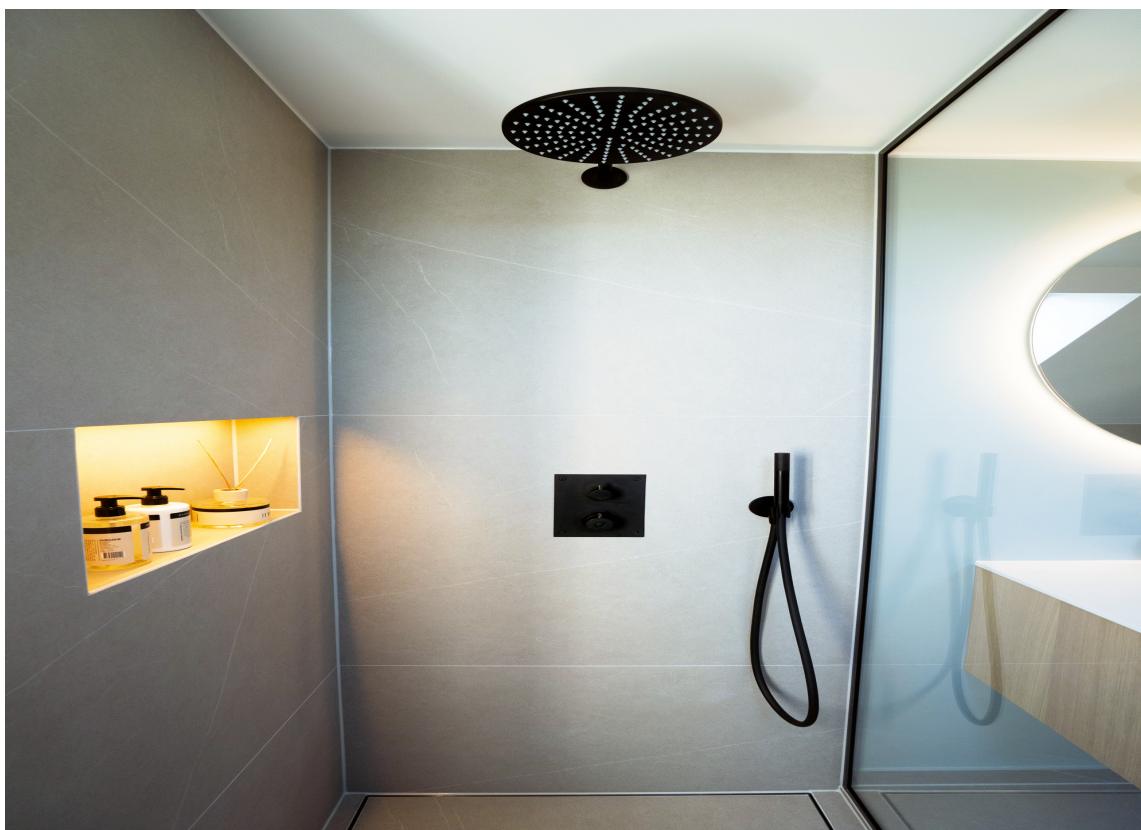
DUSJER I LUKSUS: Etter nøye overveielse valgte huseieren store fliser. Dusjen er like bred som en flis, og dusjveggen går helt opp til taket. I ytterveggen er det bygget en praktisk nisje for oppbevaring av remedier familien trenger.
