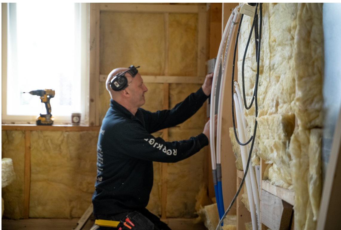
VÅTROMSNORMEN: Huset ble bygget i år 2000, med et stort hjørnebadekar. Nå ønsket huseierne en mer optimal planløsning og badet ble revet inn til bærekonstruksjonen. Romerike bad bygget det opp igjen etter våtromsnormen.
