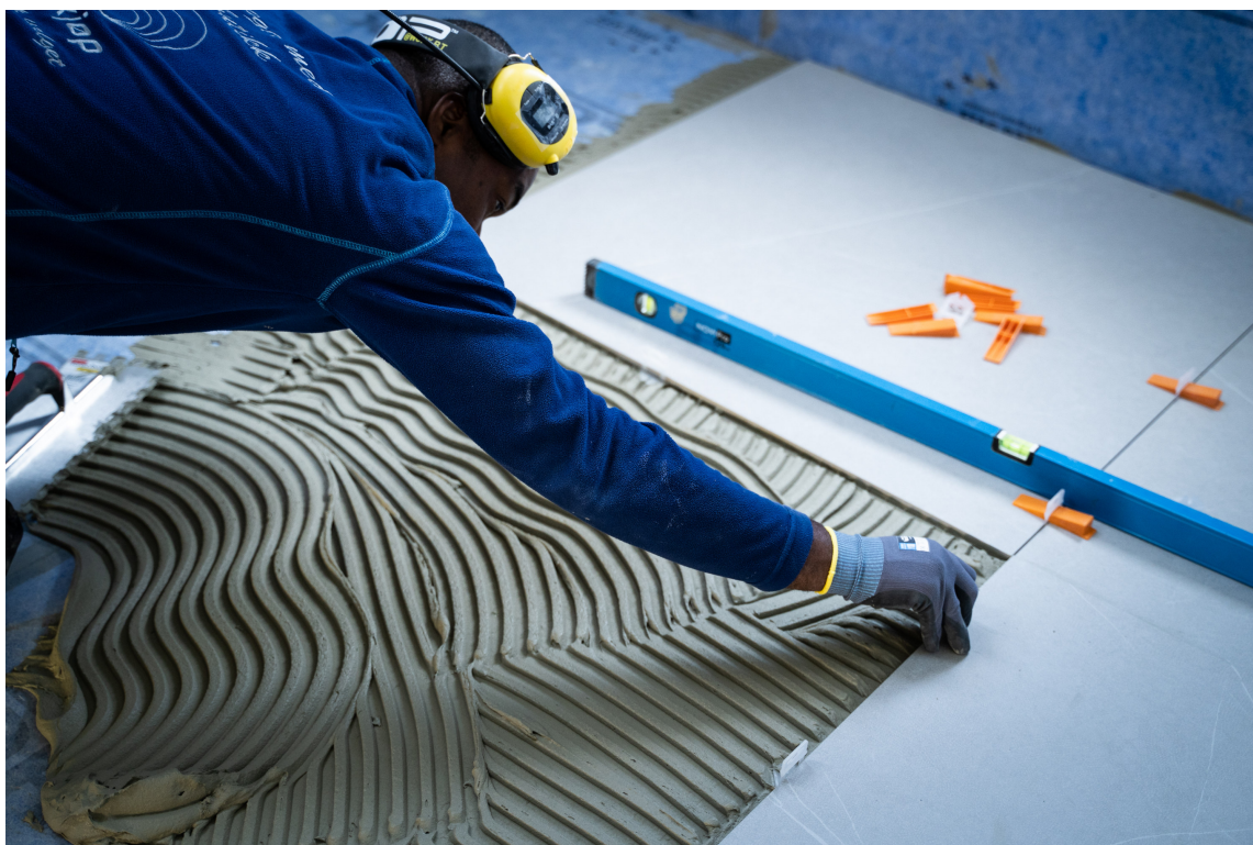
HELE JOBBEN: Romerike bad, som inngår i Rørkjøp-kjeden tok hele jobben – fra riving til innredning av det nye badet. Det er valgt skjult rørapplegg, med blandebatterier som er bygget inn i veggene.
