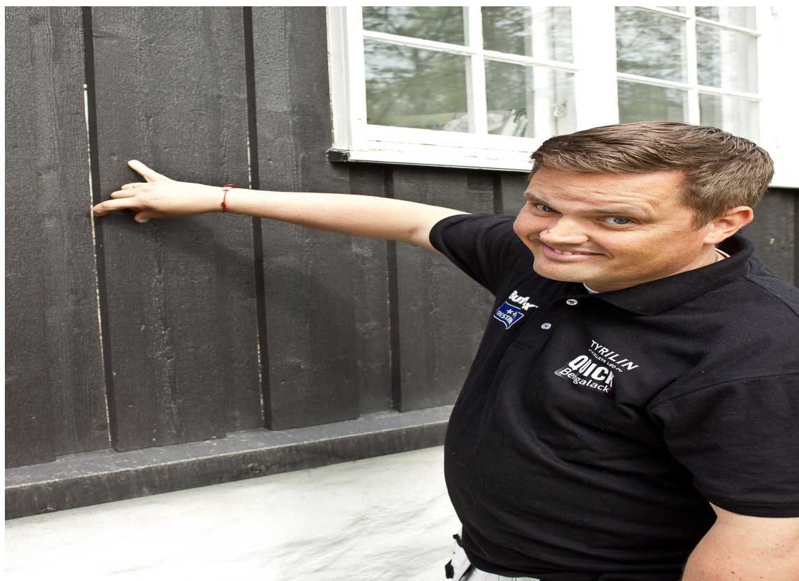
FASADEN: Thomas Løvald hos Butinox sjekker tilstanden på huset. Det bør du også gjøre.
