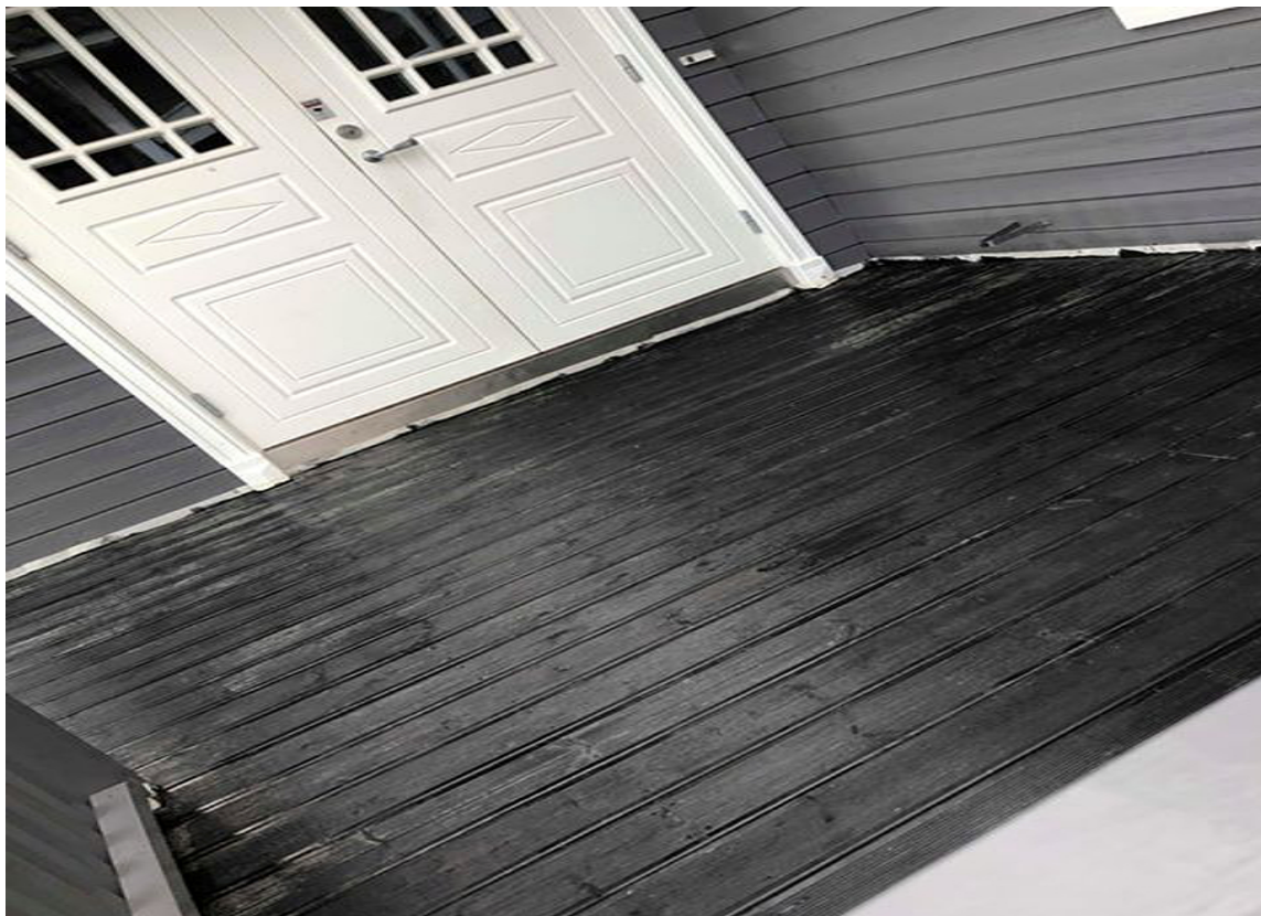
OVERFLATEFILM: Terrassebeis skal påføres slik at behandlingen trekker inn metter veden. Det skal ikke dannes sjikt på toppen.
