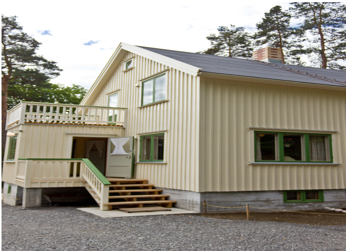
FINNMARKSHUSET: FINNMARKSHUSET: Siden linoljemalingen har god vedheft, flasser den normalt ikke av. På Norsk Folkemuseum er det fra i år utstilt et gjenreisningshus fra Finnmark som er bevart og overflatebehandlet på opprinnelig måte.
