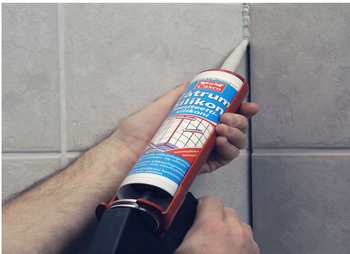
MUGGFRITT: Cascos våtromssilikon er antimuggbehandlet og brukes til fugging mellom fliser mot gulv og i hjørner, eller andre fuger i våtsoner.
