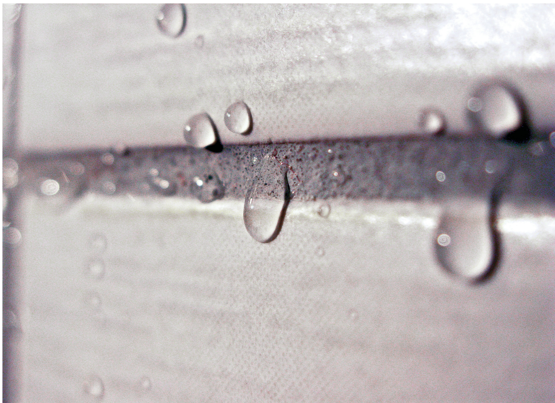
PENT OG TRYGT: Fugeimpregneringen gjør at fugen ikke trekker til seg vann og såperester.
