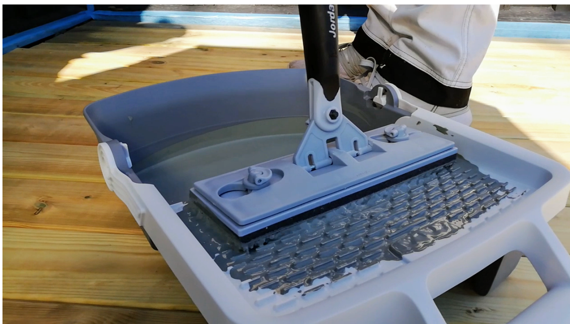
BEIS: Det finnes terrasseverktøy som gjør jobben enklere. Med en pad påføres og strykes beisen ut samtidig.
