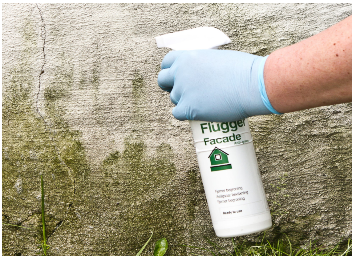
ANTIBAC: Biocider er desinfiserende og dreper sporer fra sopp og begynnende algevekst.
