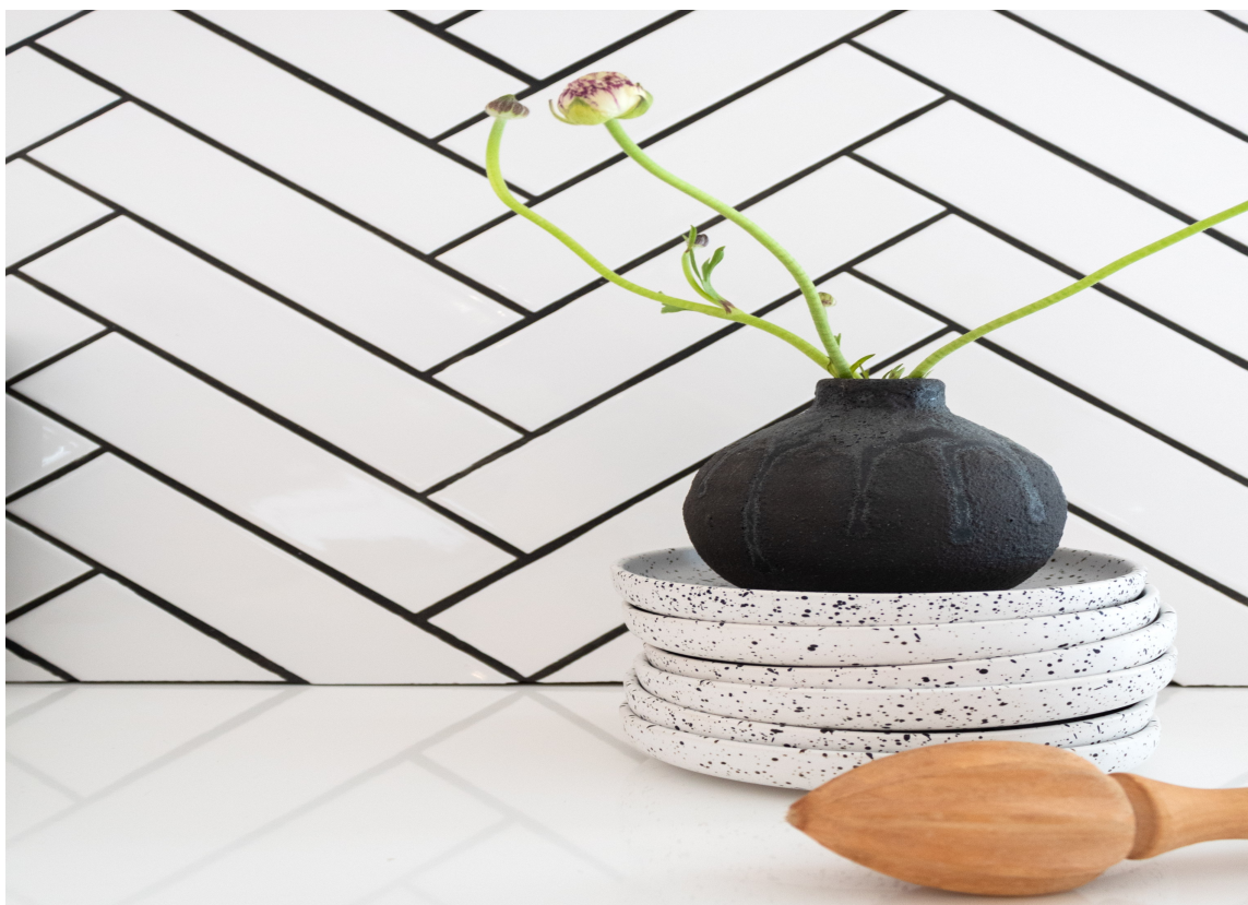
FREMHEV MØNSTERET: Med fugemasse i en fravikende farge fremheves mønsterlegging av avlange fliser i fiskebeinsmønster.
