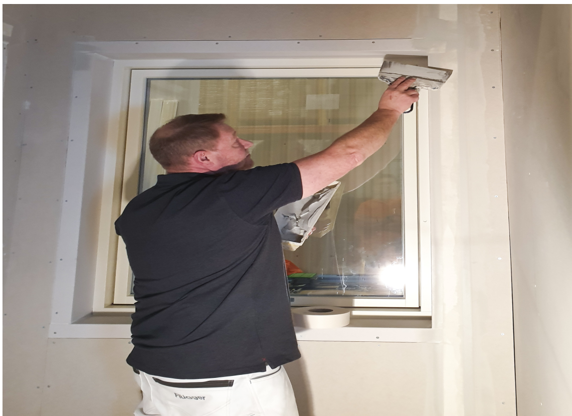
SPARKEL OG REMSE: Maleren slipper å montere hjørneløsning. Her er det kun sparkling og remsing rundt vinduet.
