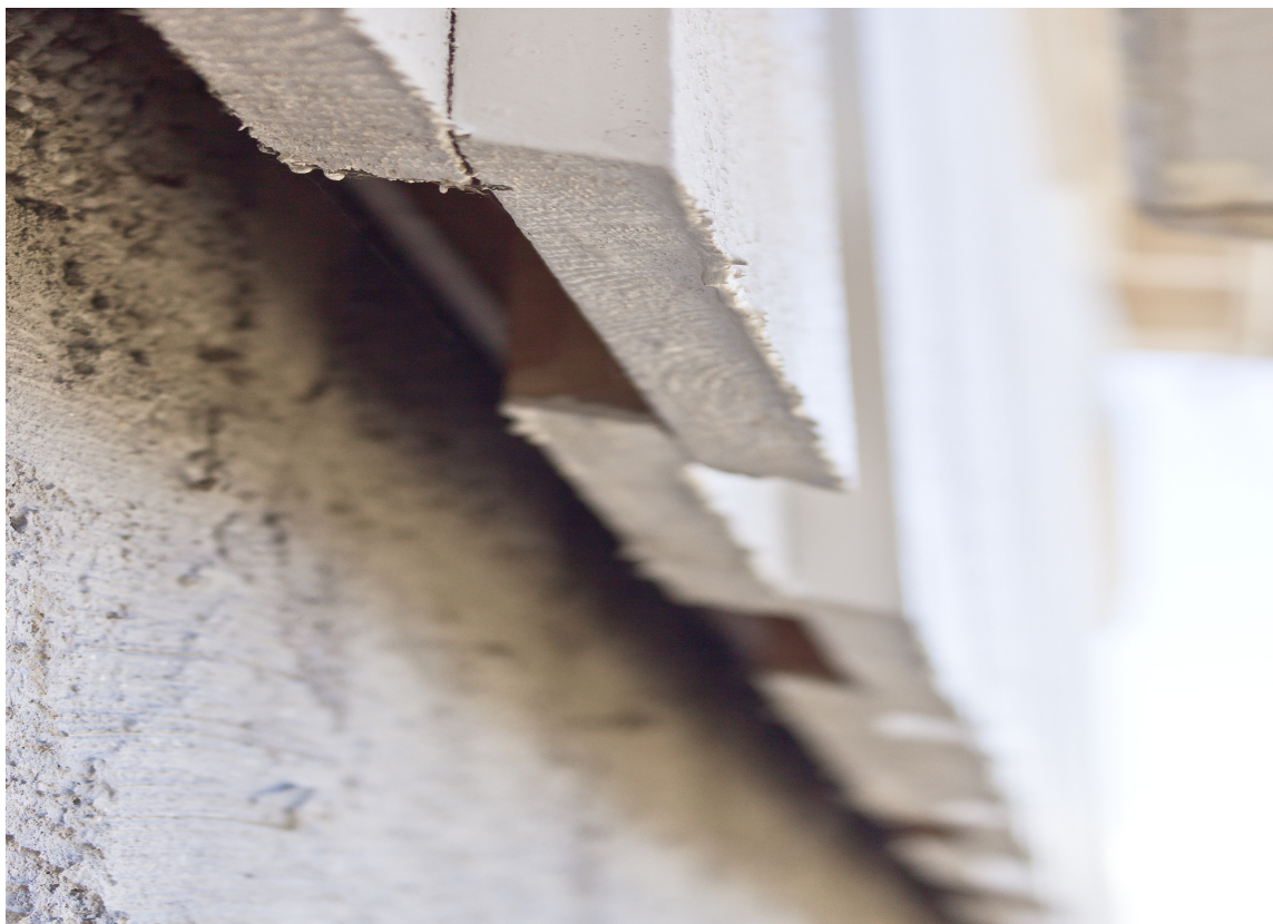
TETT TRE: Et godt grunnarbeid er den beste forutsetningen for at det skal kunne gå lengst mulig tid før behovet melder seg. Spesielt er grunning og endevedsforsegling avgjørende.
