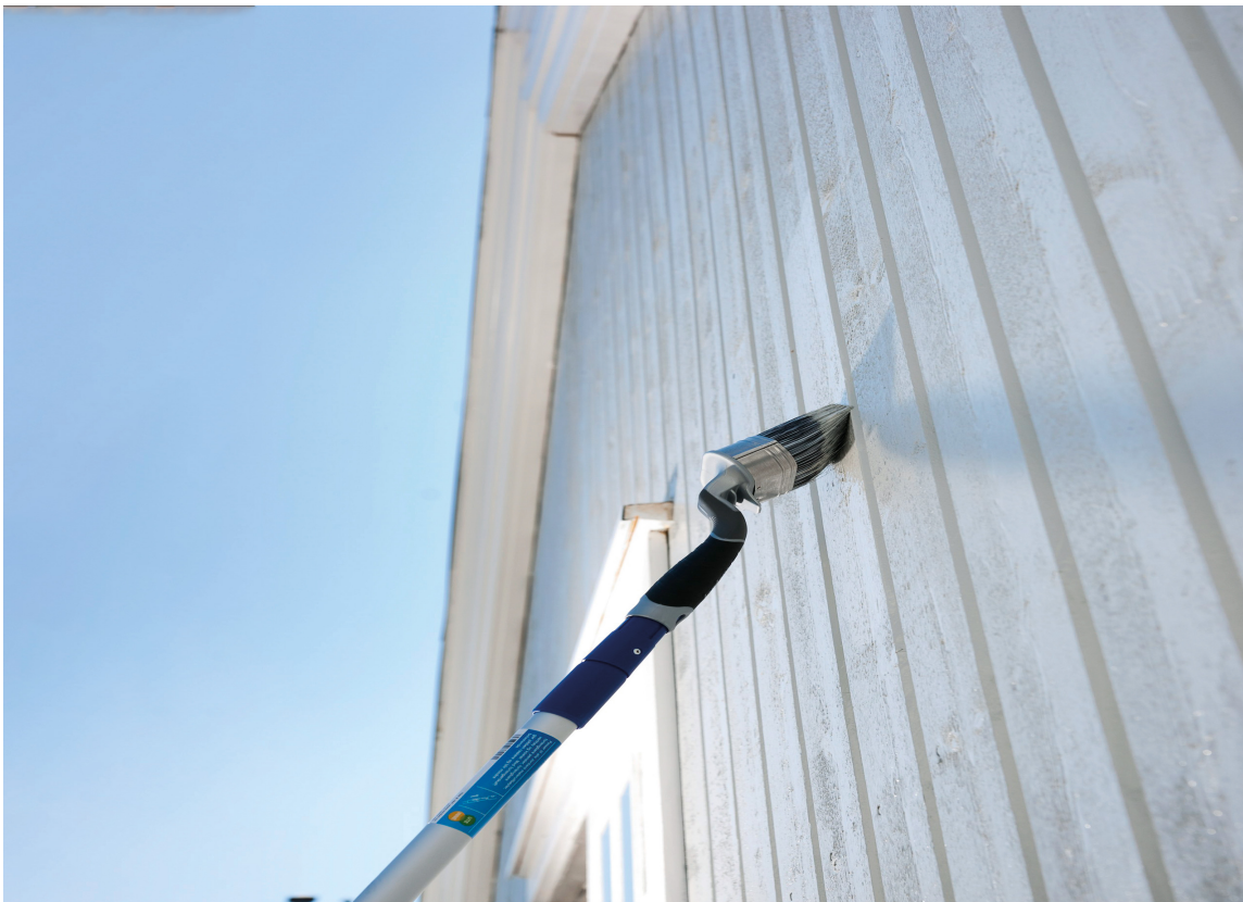
LANGT SKAFT: Sett både rull og pensel på forlengerskaft, så rekker du høyere opp og sparer kroppen for mye tøy og bøy. Her er Jordan Ultimate Pensel Oval Ergonomisk 75mm på forlengerskaft.
