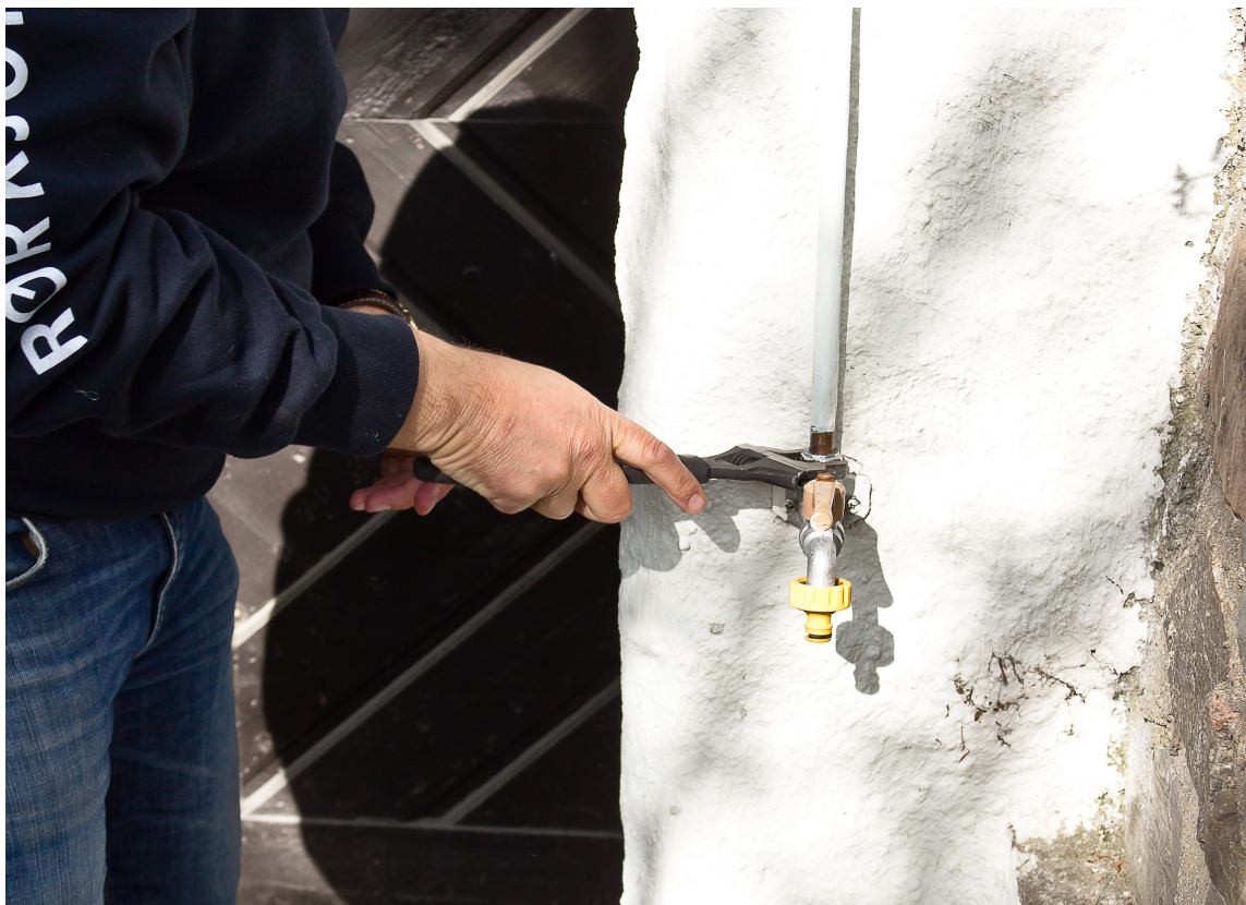
FROSTSKADE: Før du skrur på vannet ute, må du sjekke at rør og kran ikke har gått i stykker i løpet av vinteren.
