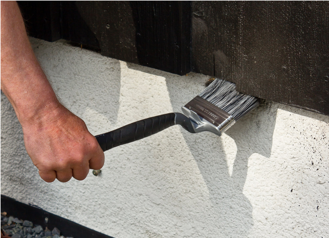
FORSEGLING: Avrund skarpe kanter, og se til å få på mye maling på endeveden. En pensel med langt skaft og knekk gjør jobben lettere.
