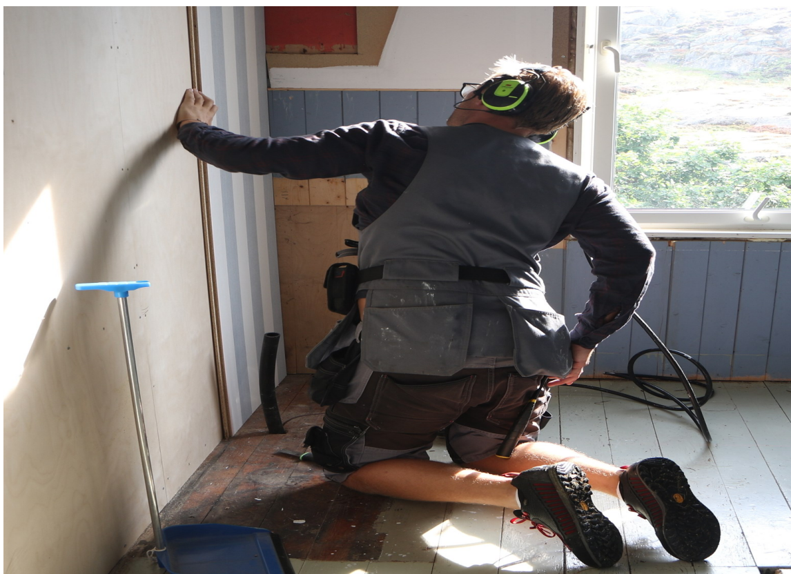
NY START: Da den gamle innredningen var fjernet ble det montert ferdig tapetserte plater utenpå de gamle veggene.
