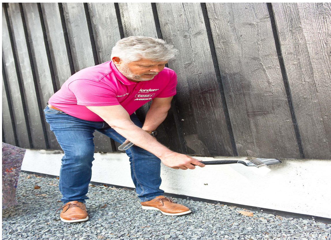
SUGERØR: Her står trefibrene som sugerør inne i veden, og trekker opp vann dersom endeveden ikke er forseglet. Lars Petter Rustan fra Jordan viser hvordan du beskytter den med en vinklet pensel og olje.
