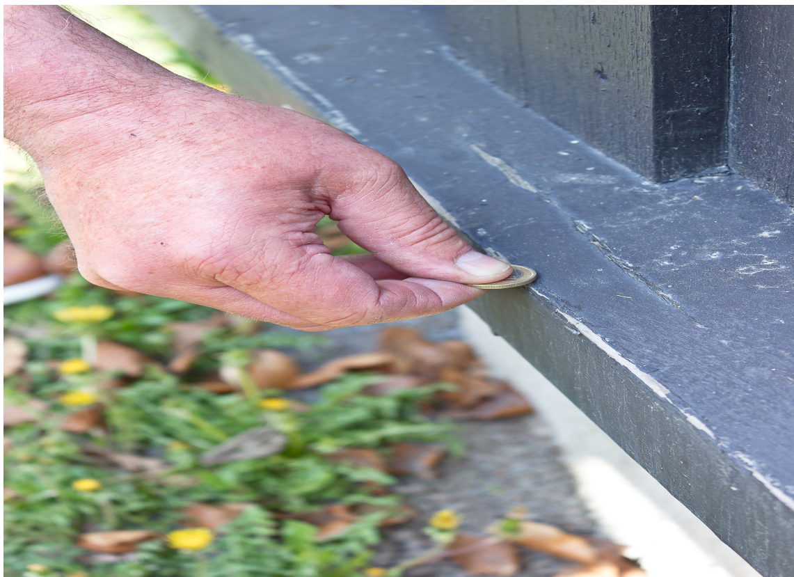
MYNTKONTROLL: Bruk en mynt som har litt avrundet kant for å sjekke om malingen sitter godt fast, tipser Lars Petter Rustan hos Jordan.
