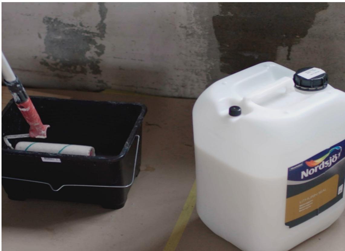
BETONG: For at de gamle betongveggene ikke skal støve, behandles de med Lithurin, et støvbindende middel fra Nordsjö.
