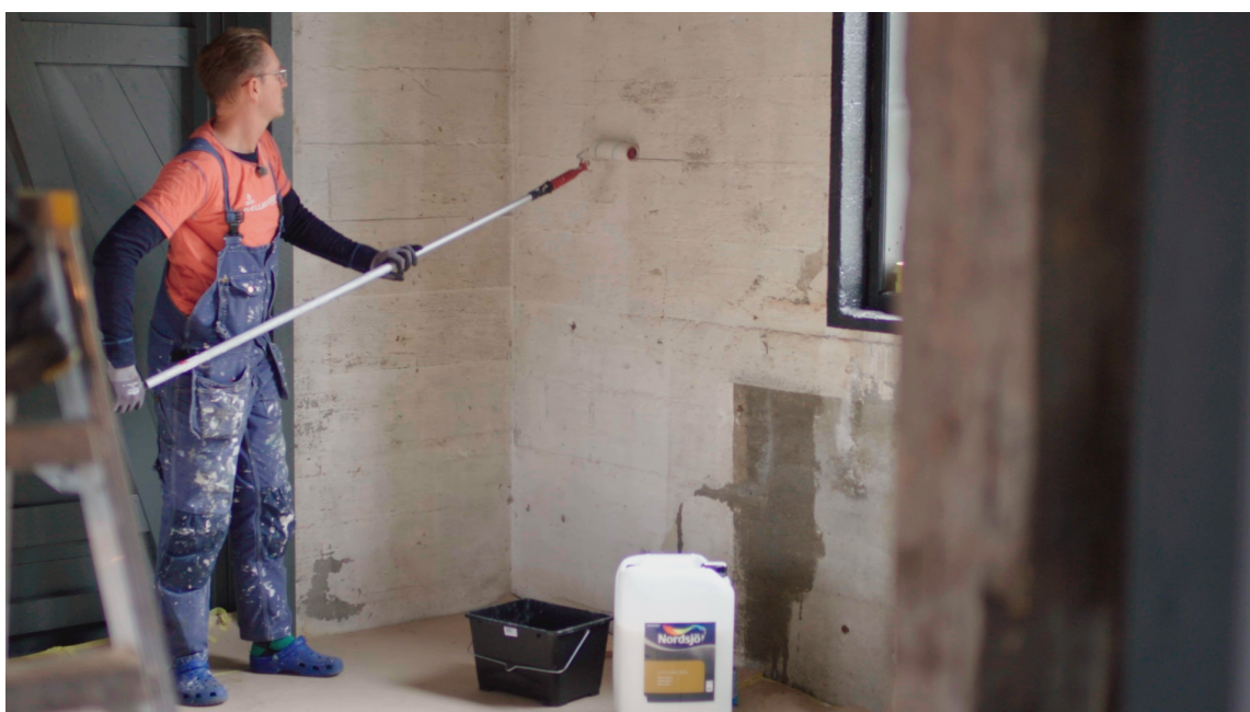
BINDER STØV: Halvor Bakke er også praktisk handyman, og med rull på langt skaft sparer han ryggen når støvbindingen påføres.
