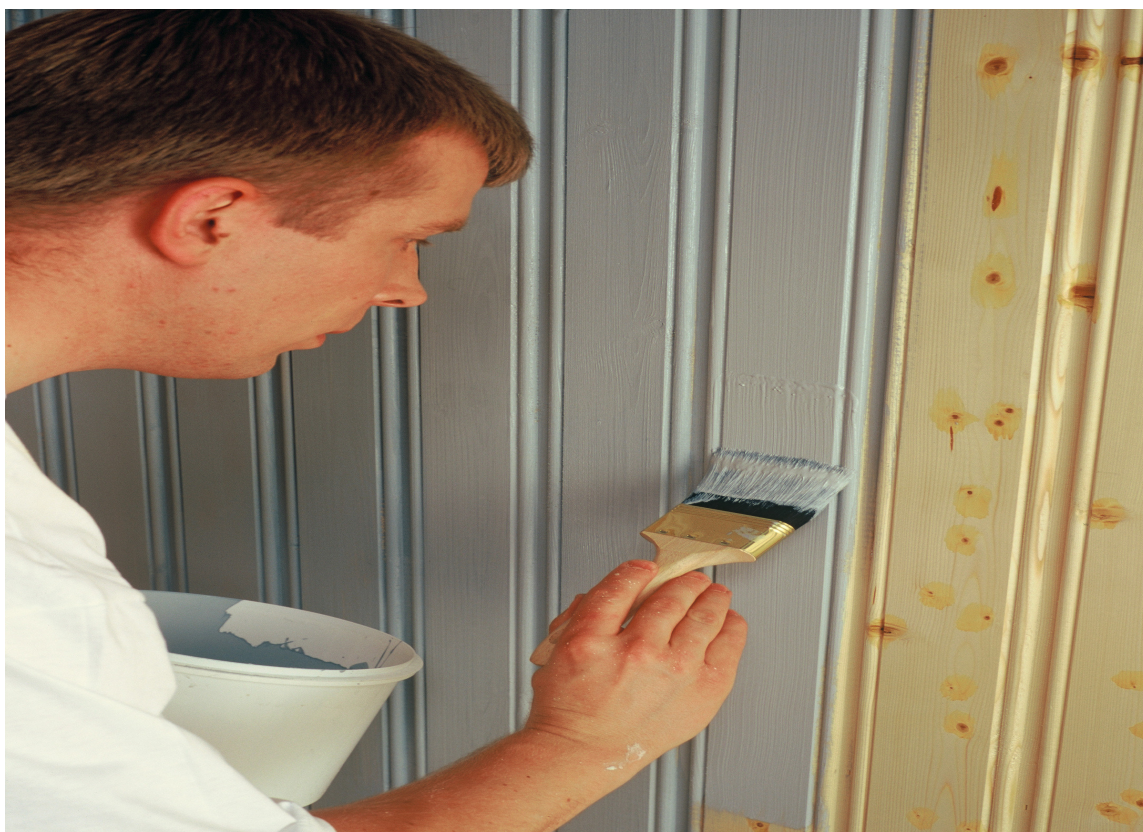
KVISTENE LEVER: Kvistene «dør» aldri, og også meget gammelt treverk kan gi fra seg fargestoffer ved overflatebehandling.
