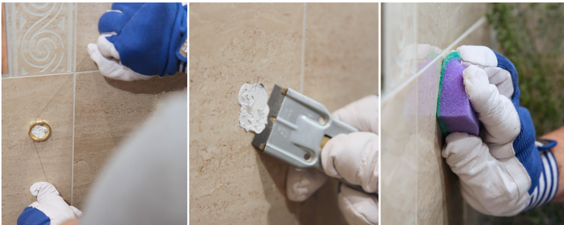
1-2-3: Så lett er det å fjerne limte detaljer fra flisene. 1. Skjær. 2. Skrap bort. 3. Vask av.
