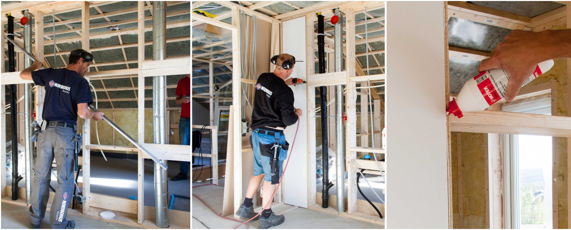
1, 2, 3: 1. Sjekk underlaget med en rettholt, 2. Start monteringen i hjørnet, og 3. Lim og klikk.
