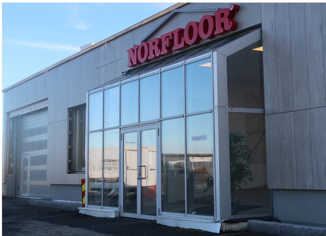
STORT FORMAT: Norfloors fasade på Tiller blir lagt merke til. Her er det montert gigantiske fliser.
