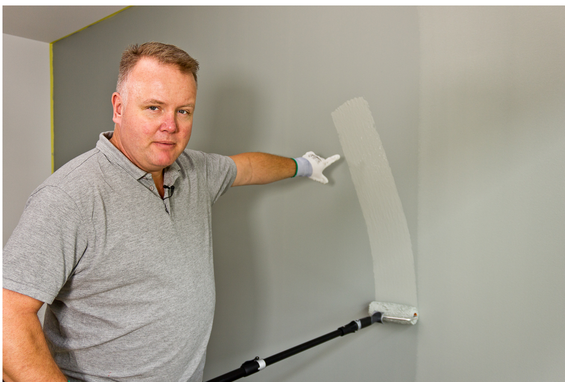
MAL V: Sett av rullen litt til siden fra der du skal male. Begynn midt på veggen og lag et malingsdepot ved å male en V.
