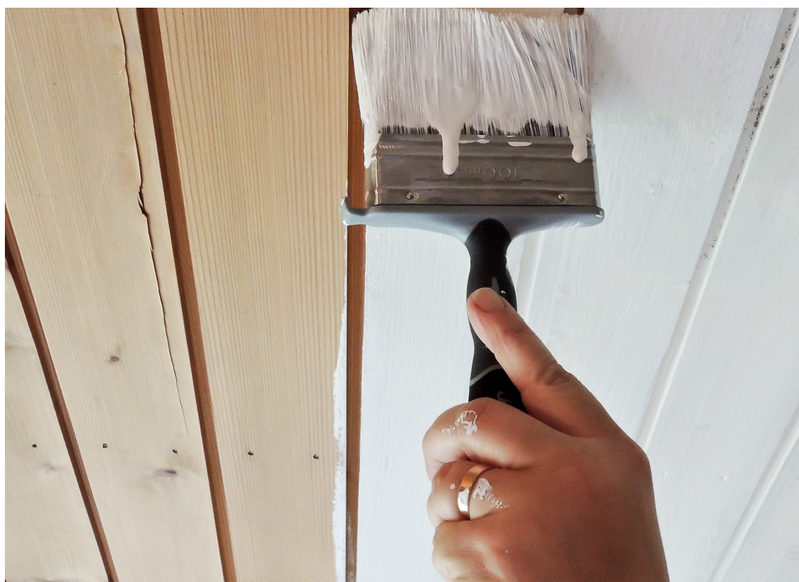
TRE STRØK: Etter tre strøk er taket ferdig malt. Den malte flaten har god vaskbarhet og cirka glans 10.
