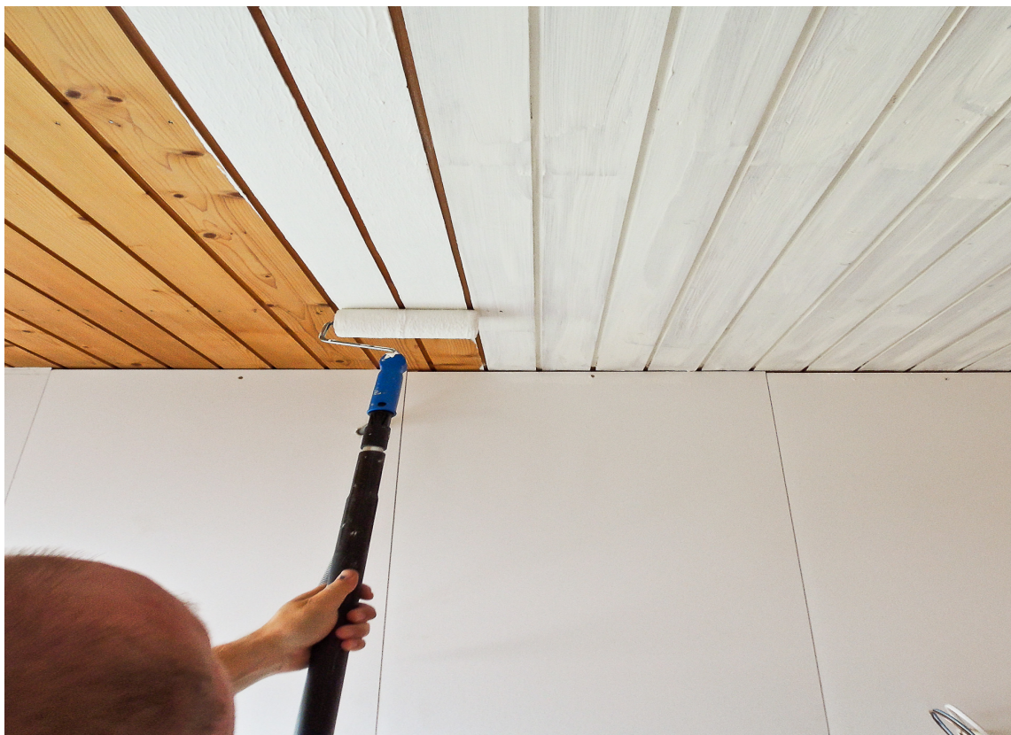
RULL UT: Med rull på forlengerskaft på påføres malingen raskt og i et jevnt sjikt.
