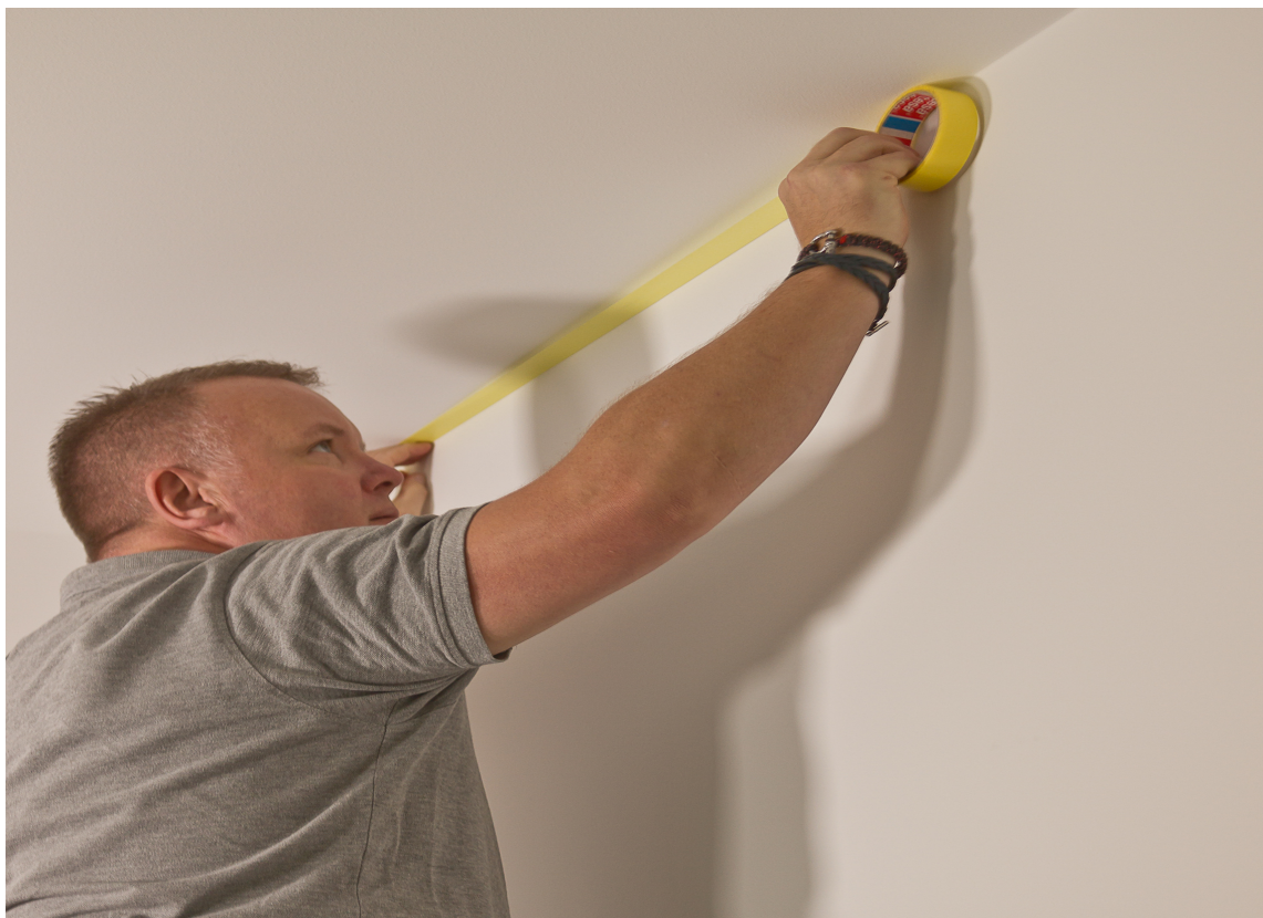
TAPE: Med riktig tape festet med lange drag mot taket er du langt på veg til fint skille når veggen skal males. Her er Morten Fehn i aksjon.
