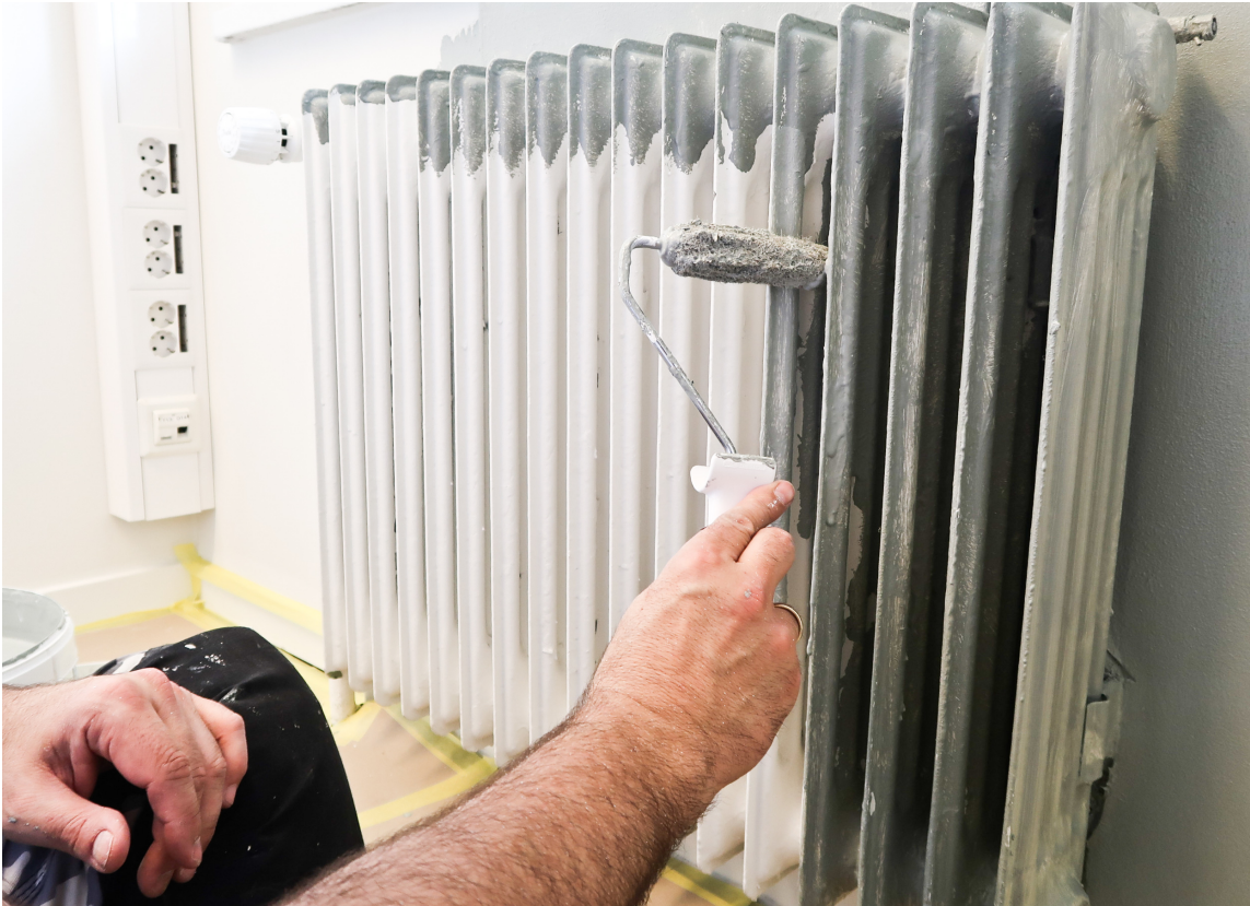
MINIRULL: En minirull brukes når du skal male på steder med dårlig plass. Enten det er på veggen bak radiatoren eller når du velger å male radiatoren i veggfargen.
